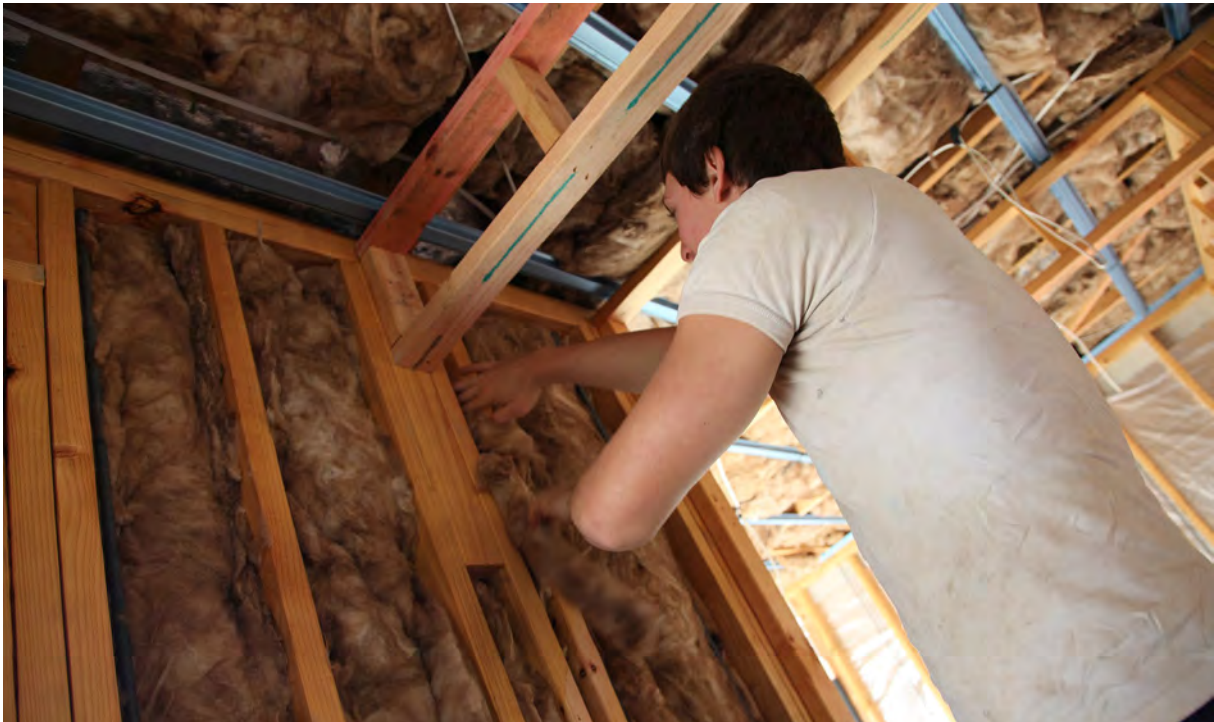
Anbringen von Wandisolierung.
