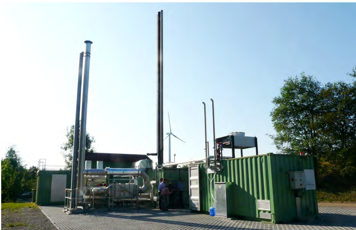
Entgasungsanlage einer Deponie
